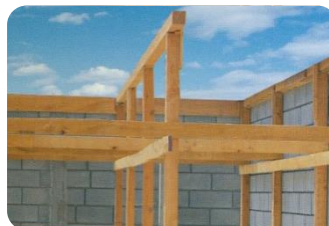
2. Montaje de Viguetas
