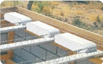
4. Montaje de Bovedillas
