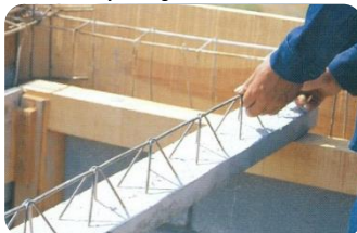
3. Alineamiento de Viguetas
