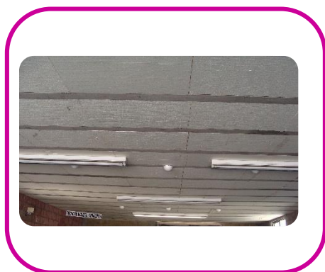
Ilustración 14 Techo de Vigueta y Bovedilla con instalaciones eléctricas.
