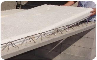
5. Colocación de Malla Soldada
